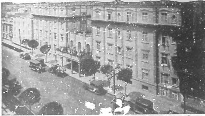
FACHADA DEL HOTEL
